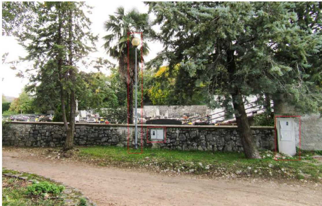
Slika 5. Istočni zid sa priključcima te pristupna cesta
