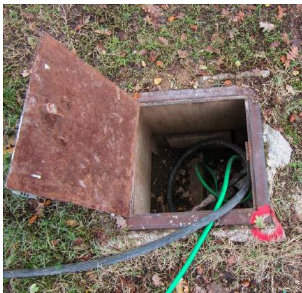
Slika 6. Priključak za vodu van postojećeg groblja
